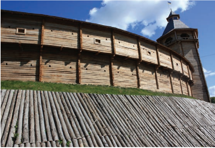
Зрубні стіни і надбрамна вежа на валі та замощений колодами рів цитаделі батуринської фортеці XVII ст. Реконструкція 2008 р. Світлина споруд цитаделі В. Мезенцева.
