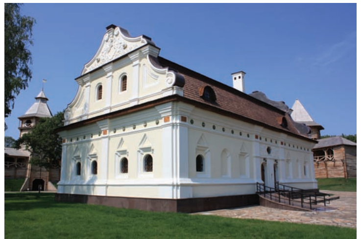
Реконструкція гетьманської резиденції кінця XVII ст. у цитаделі. Вигляд з південного сходу.
