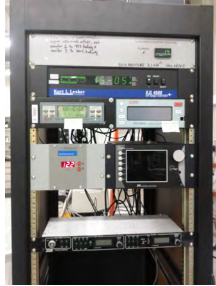
(d) The control panel for the e-gun deposition system.
