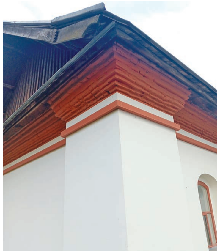
Іл. 19. Реставровані потиньковані й побілені цегляні Північні келії другої половини XVII ст. Єлецького монастиря у Чернігові з профільованим карнизом та архітравом, пофарбованими червоно-вохристом кольором. Знімки С. Дмитрієнка 2025 р.
