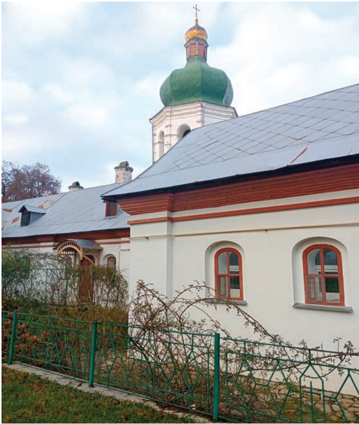
Іл. 19. Реставровані потиньковані й побілені цегляні Північні келії другої половини XVII ст. Єлецького монастиря у Чернігові з профільованим карнизом та архітравом, пофарбованими червоно-вохристом кольором. Знімки С. Дмитрієнка 2025 р.
