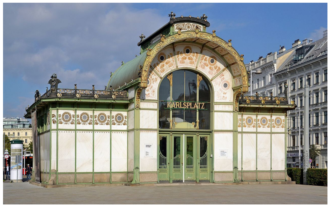
Otto Wagner (AT) and Joseph Maria Olbrich (AT), 1899, Karlsplatz Stadtbahn Station, Vienna, photo source: Wikimedia Commons
